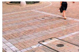
<그림Ⅳ-1-2> 바닥포장패턴과 일체화된 맨홀 설치 사례
