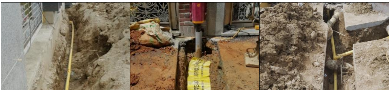
[그림] 도시가스인입공사 예시
