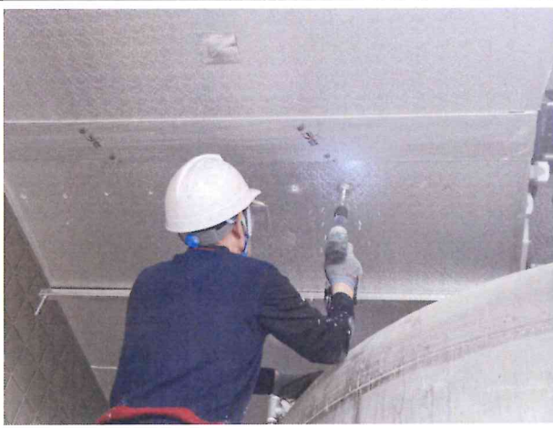
장 비 명 : 충전 드릴 측정 내용 : TEST HOLE 작업
