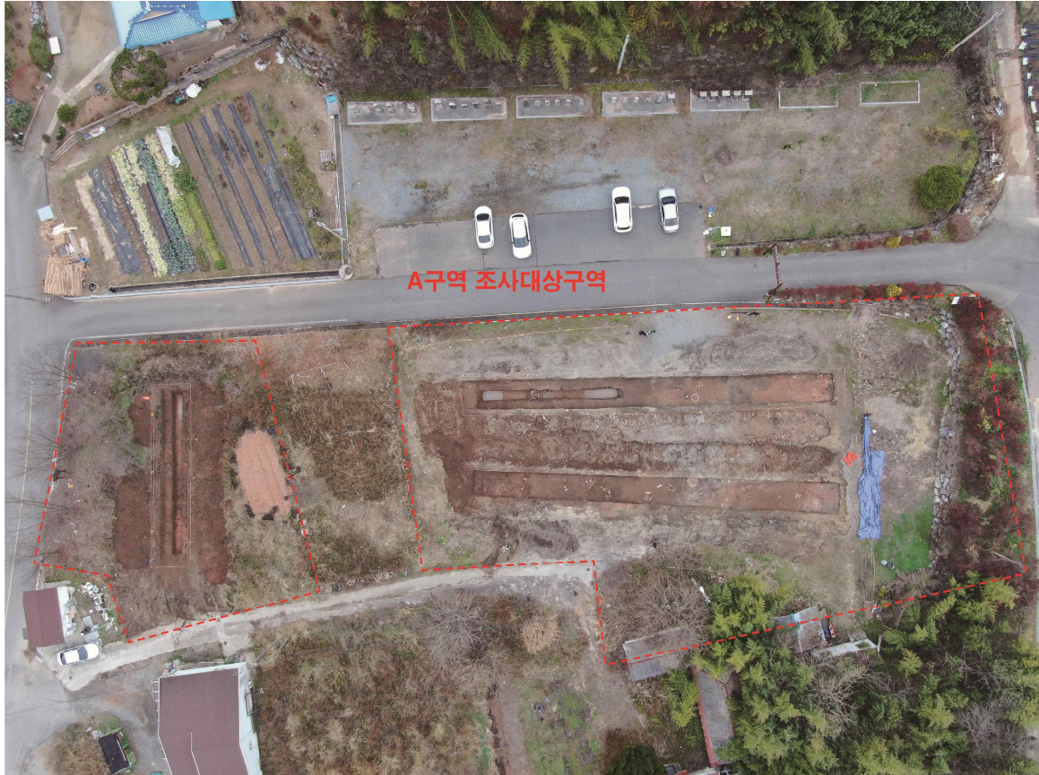
사진 3. 군산 옥구읍성 A구역 조사 후 전경
