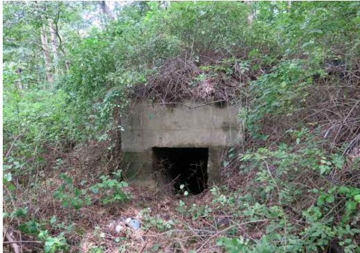
박스 형태의 콘크리트 구조물로 되어 있는 엄폐호로 무덤의 봉분처럼 윗부분을 덮어 놓음
