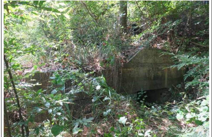
엄폐호의 전경, 거대한 콘크리트 구조물로 입구 상부는 지붕의 구조를 하고 있음
