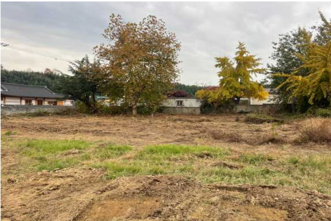
사진 38. 복토 후 전경1
