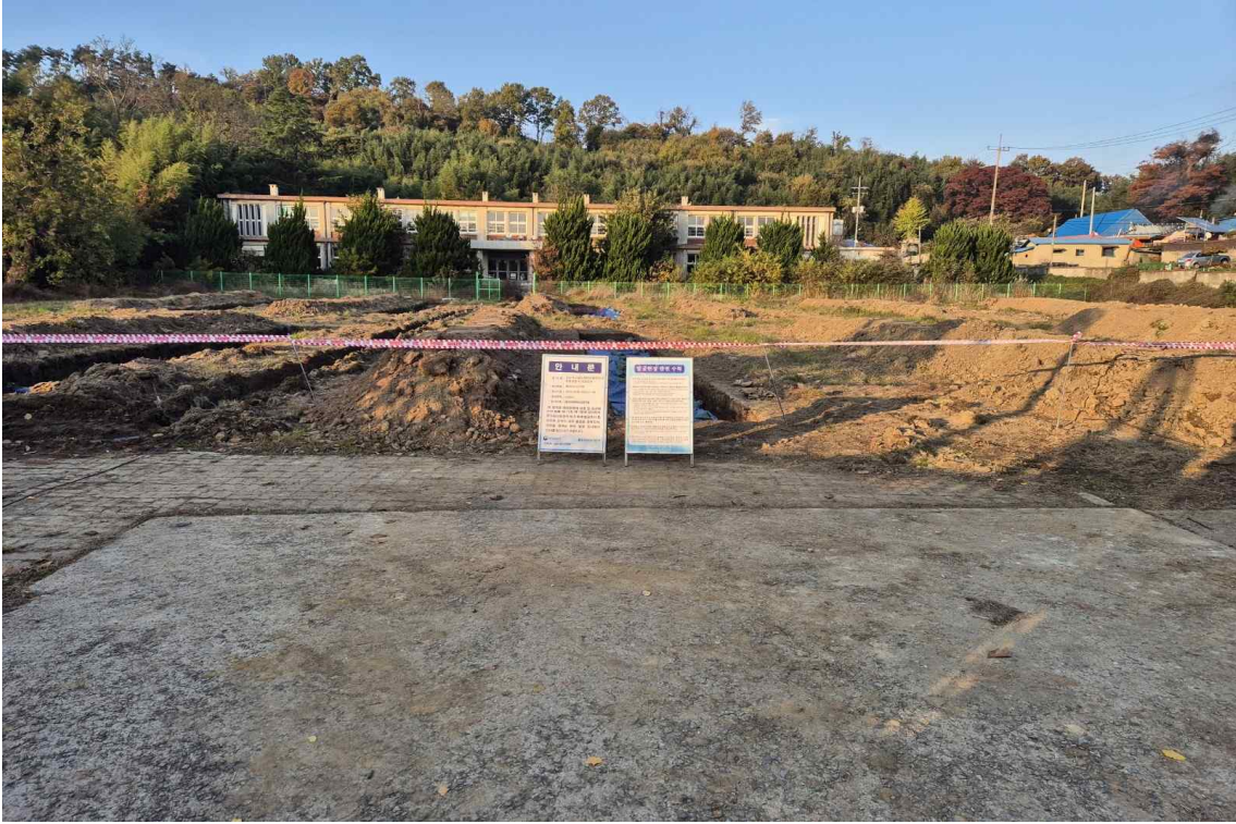
사진 33. 안내판 설치 및 안전조치
