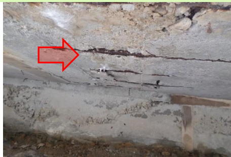
14. 남전주택(1) 발코니 슬래브
