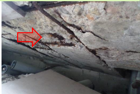
6. 경암선한연립 발코니 슬래브
