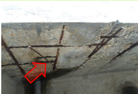
15. 남전주택(2) 발코니 슬래브
