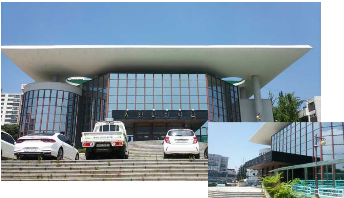
<그림 2-14> 군산시민문화회관 전경
