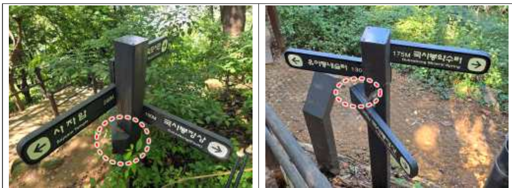
<그림 > 기존 지주에 보조목 활용하여 직각형태를 극복한 사례사진
