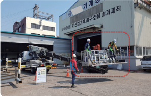
차량탑재형 고소작업대로 승강 시 안전대미착용으로 떨어짐 위험
