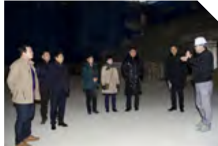
군산실내배드민턴터장 건립사업 현장(행정복지위원회)
