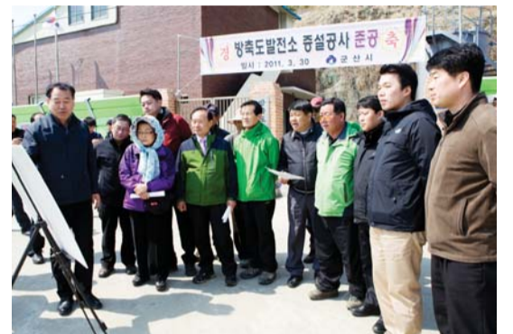
경제건설위원회 방축도발전소 증설공사 현장
