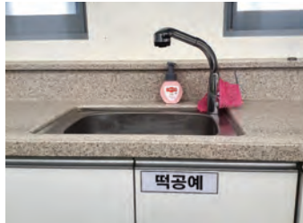
수업용 물비누 설치
